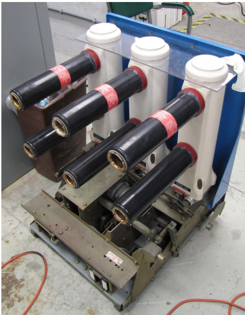
**Figura 1.16: La construcción interna de un disyuntor de 13,8 kV**
