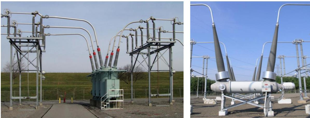
**Figura 1.15: Disyuntores de alto voltaje**
